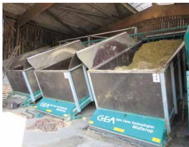
Photo 6.10 : GEA demande une hauteur > 4 m au-dessus des stockeurs
