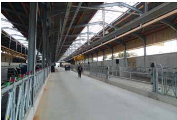
Photo 7.2 : Les rails disposés en « U » permettent une distribution de part et d'autre du large couloir de distribution central
