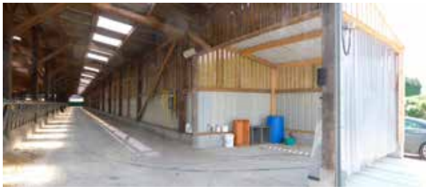
Photo 11.1 : Entrée déportée pour le robot, fermée par un portail fait de lanières plastiques ce qui permet de maintenir fermé le grand portail du couloir d'alimentation les jours de vent et de pluie
