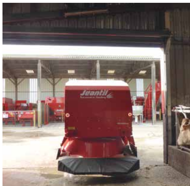
Photo 7.9 : Porte électrique en filet enroulable à ouverture automatique déclenchée lors du passage du robot
