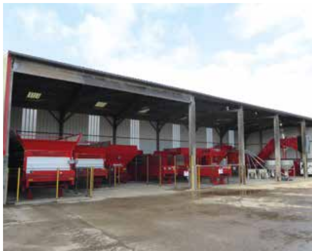
Photo 6.5 : Cuisine avec tables et stockeurs Jeantil et suppression d'un poteau pour accéder plus facilement aux stockeurs (ensilage en vrac)
