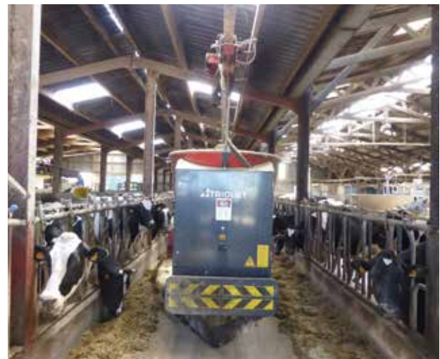
Photo 7.6 : Un couloir d'alimentation réduit ici à 3,10 m de large avec un rail central unique pour un fonctionnement de l'automate en va-et-vient avec distribution des deux côtés
