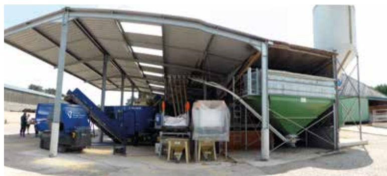
Photo 6.7 : Cuisine DeLaval : Accès de l'automate à la mélangeuse par le pignon Nord et façade Est totalement ouverte
