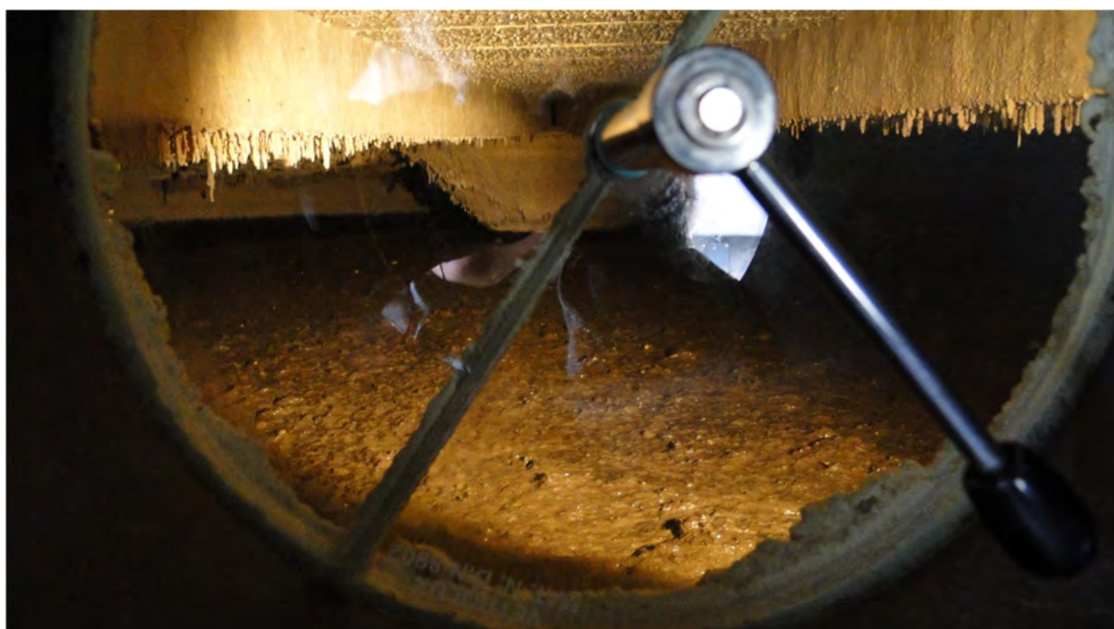
Intérieur d'un digesteur
