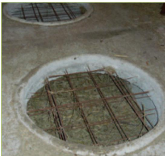
Arrivée d'air pour un séchoir à balles auto-construit
