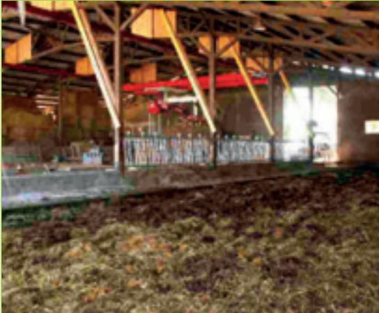
Une charpente renforcée pour installer une griffe.
