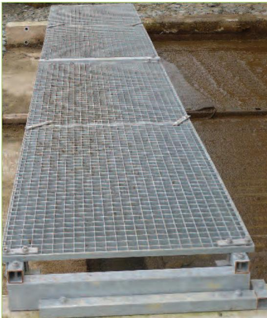
Photo 15 : Protection au-dessus d'un canal à lisier.
