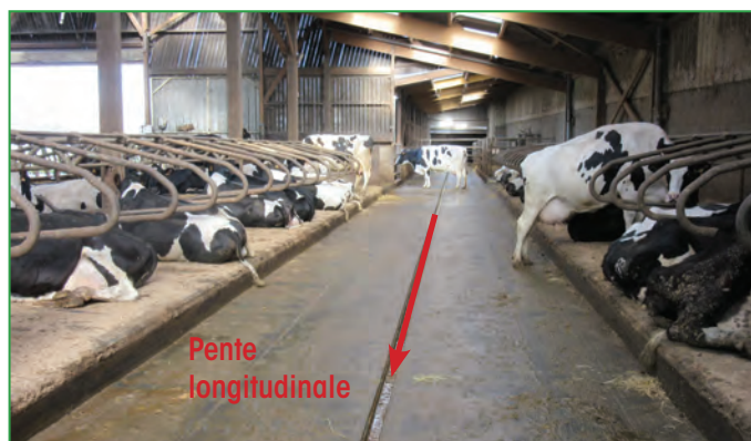
Photo 9 : Pente longitudinale d'un couloir de circulation
