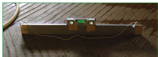
Photo 7 : Mesure de la pente avec un niveau électronique posé sur une barre métallique
