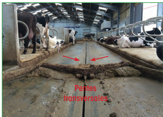
Photo 10 : Pentes transversales vers le rail du racleur d'un couloir de circulation
