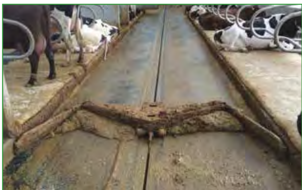
Photo 30 : Couloir en asphalté avec pente en V
