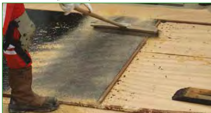
Photo 15 : Puis, répartition/homogénéisation du sable en surface au balai et élimination de l'excédent. Après balayage, poursuite de l'épandage sur la nouvelle partie d'asphalte dernièrement coulé.
