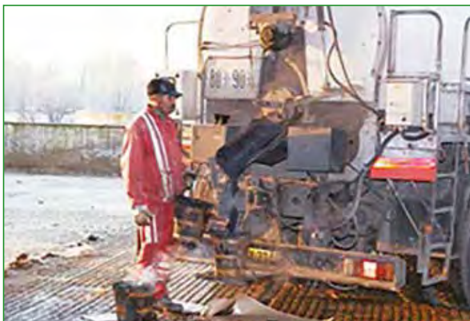
Photo 9 : Camion chauffant maintenant le produit à température à 200°C maximum. L'asphalte est versé dans des seaux en bois par le chauffeur.
