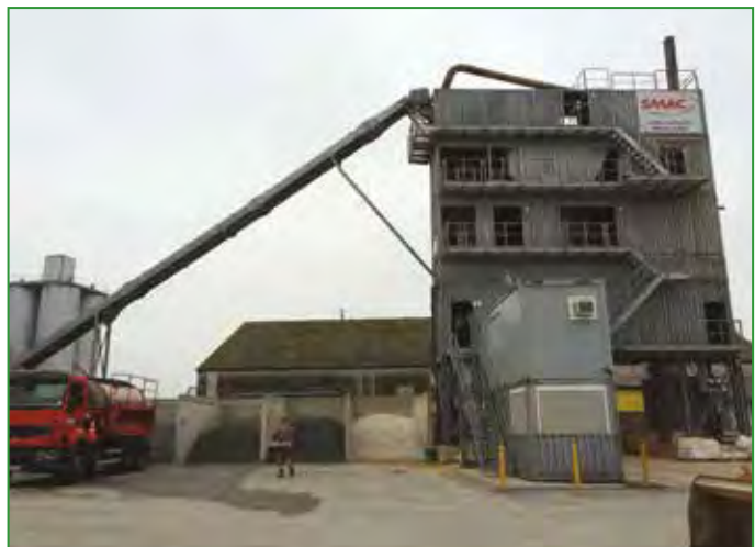
Photo 1 : Les centrales de fabrication de l'asphalte sont peu nombreuses sur le territoire (sur la photo celle de la SMAC à Rennes pour la Bretagne et les Pays de la Loire) mais grâce aux camions calorifugés et chauffants, le transport de l'asphalte à 200°C peut se faire sur de longues distances
