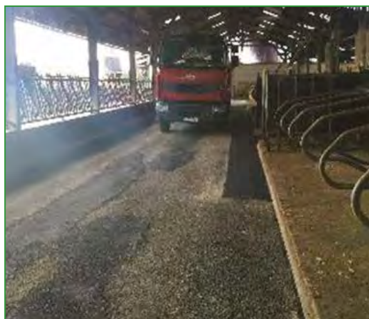
Photo 2 : Avant de débuter le chantier, le sol doit être très bien nettoyé, dépoussiéré et réparé localement si besoin comme dans le cas de cet élevage
