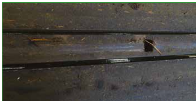
Photo 21 : Les racleurs étant aussi usagés, ils ont été remplacés lors de la rénovation des sols. Après sciage de l'ancien béton, les rails ont été installés et surélevés de la hauteur de la couche d'asphalte. Les bordures ont donc servi de coffrage pour les 2 cm d'asphalte.
