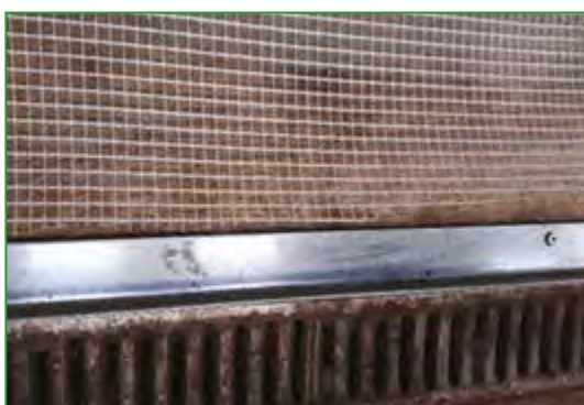
Photo 4 : Dans cet exemple, la grille est déroulée devant le caniveau d'évacuation sur le papier kraft et maintenue par une cornière.
