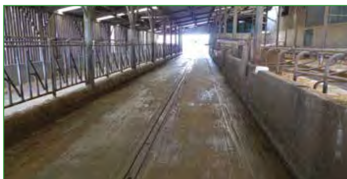
Photo 19 : Couloir d'alimentation, raclage de lisier
