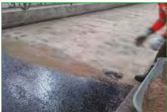
Photo 14 : Au fur et à mesure du coulage, épandage immédiat de sable manuellement en surface. L'objectif est que le sable intègre le bitume en surface encore chaud
