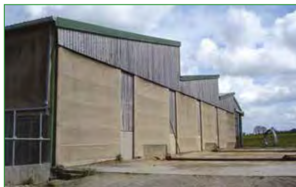
Photo 27 : Vue extérieure du bâtiment, toiture en sheds
