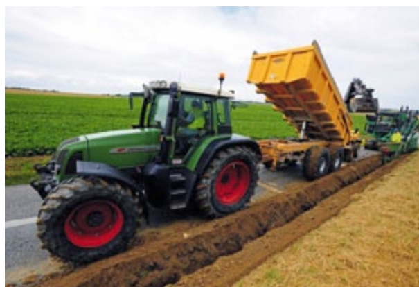
Enfouissement de ligne à Frémainville (Val-d'Oise) : creusement d'une tranchée et enfouissement de câbles à l'aide d'une trancheuse
